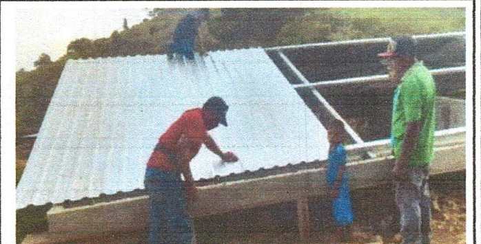
Foto 4: Mantenimiento de la estructura de láminas
