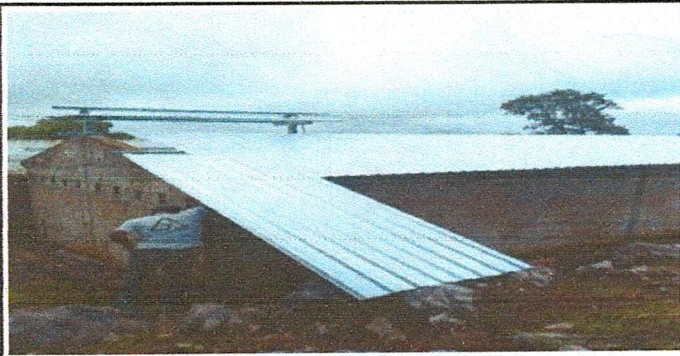
Foto 5: Mantenimiento de estructura de láminas de la cocina
